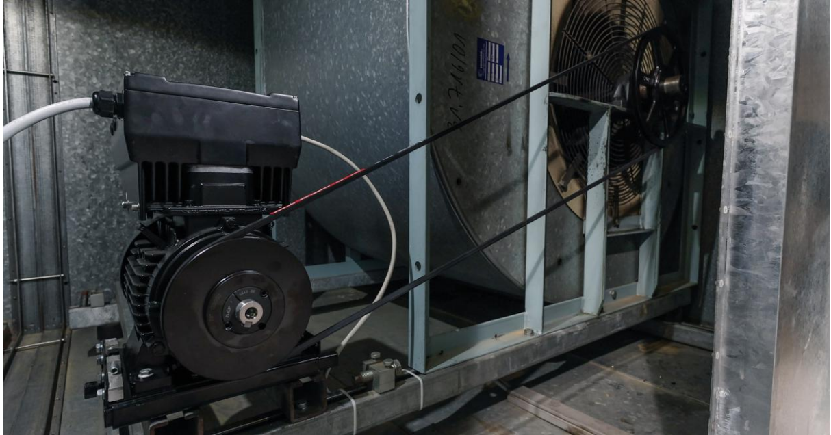
Beispielhafte Einbausituation des ZITT-Antriebssystems
